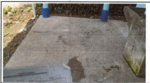
FOTO 12: Reparación de planchas de concreto de patio II
