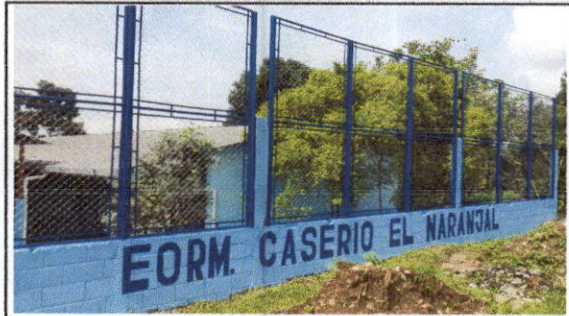
FOTO 8: Reparación de tubo hg y malla galvanizada PATIO I
